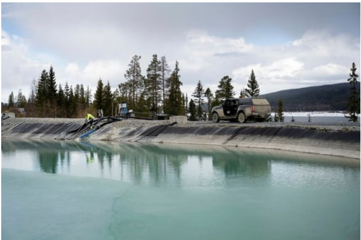
Den topasblå sedimentationsdammen ligger mitt inne på området. Här faller det zinkhaltiga slammet till botten för att senare pumpas bort. Foto: Erik Abel
