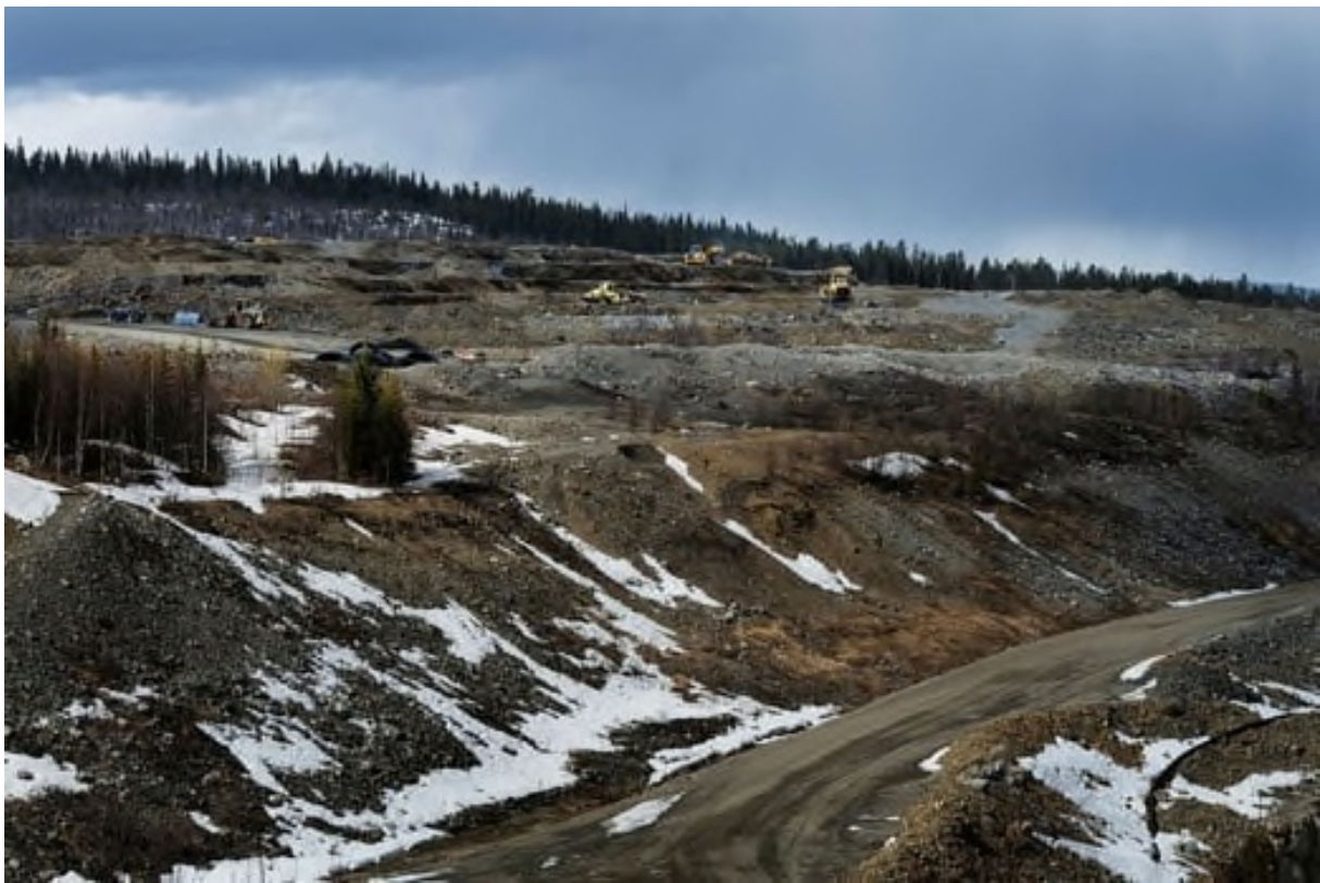
500 000 kubikmeter krossad sten läggs i trappsteg för att senare kunna täckas med jord. Foto: Erik Abel
