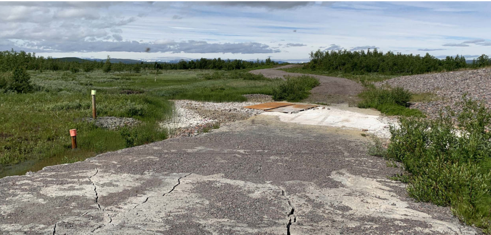
FIGUR 17 Vägöverfarten där Luossajärvis utloppskanal mynnar i en våtmark öster om Pahtajoki. Kanalens tillrinning sker från höger i bild, den var dock torrlagd vid fototillfället 30 juni 2021. Överfarten är inte ordnad för biltrafik utan lämpar sig i dagsläget endast för mer terränganpassade bilar. Endast behöriga fordon kör längs vägen i dagsläget.
