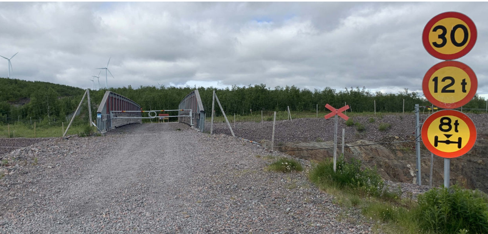
FIGUR 16 Viadukten över den södra järnvägen som är belägen några hundra meter nordväst om parkeringen söder om E10. Här passerar både skoterled, skidspår och sommarled upp mot Ädnamvaara. Bron klarar personbilar men är mötesfri och inte anpassad för någon omfattande trafik. Endast behöriga fordon nyttjar bron i dagsläget.
