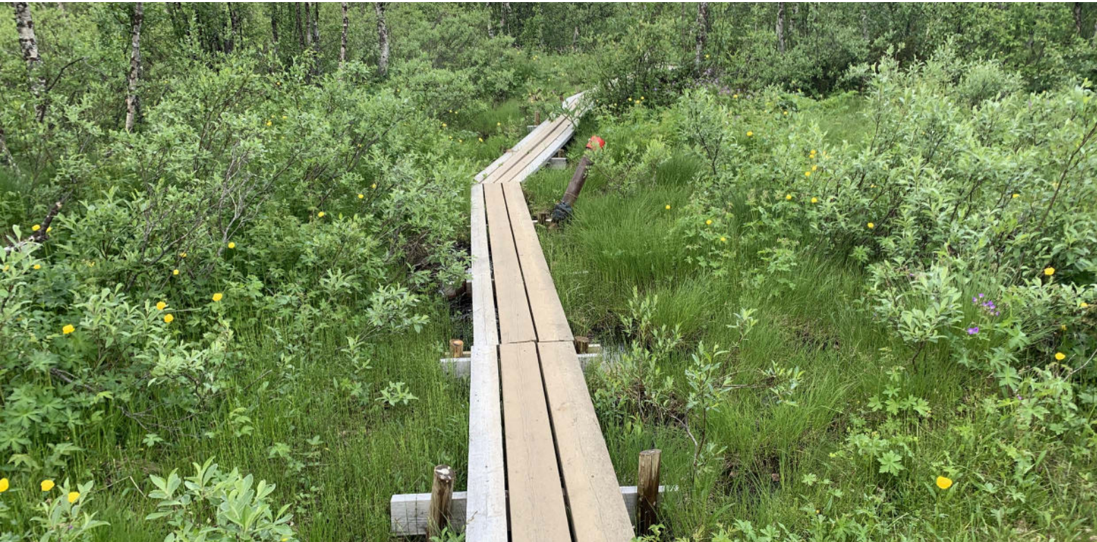
FIGUR 6 Spångningen av sommarleden upp till Ädnamvaarasstugan har gjorts relativt bred och med små spalter mellan brädorna för att göra det enklare och säkrare för cyklister att ta sig fram.
