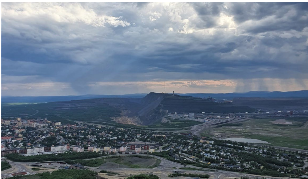
Figur 4.2. Kiirunavaara och delar av Kirunas bebyggelse 2020. Fotot är taget vid ungefär samma plats som fotot ovan och illustrerar hur platsen förändrats över tid. Foto: Judit Malmgren
