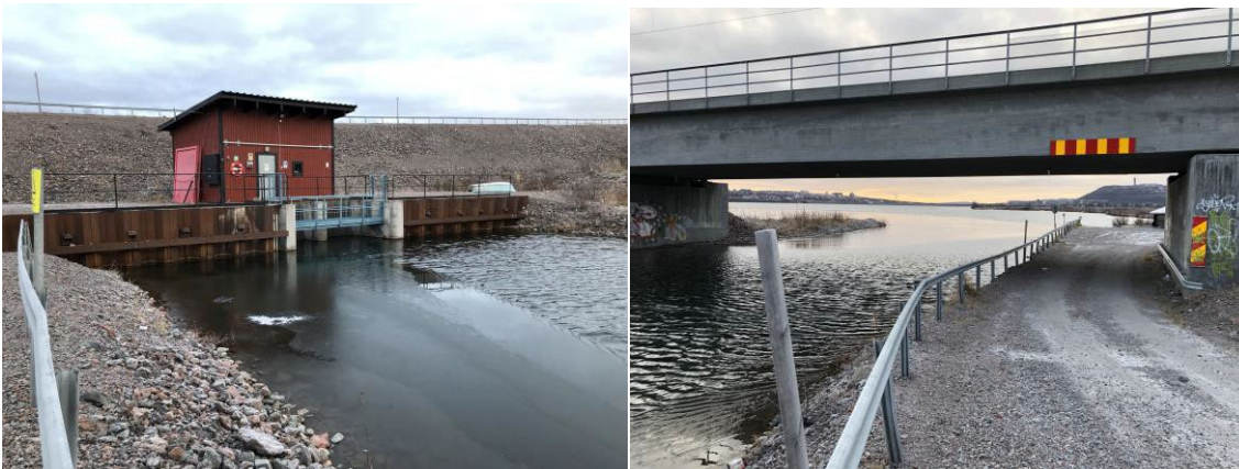
Figur 2-8. Bild av utskovet som reglerar vattenflödet norrut från Luossajärvi (vänster) samt järnvägsbron precis US utskovet. Båda bilderna är tagna vid platsbesöket den 14 oktober 2021.
