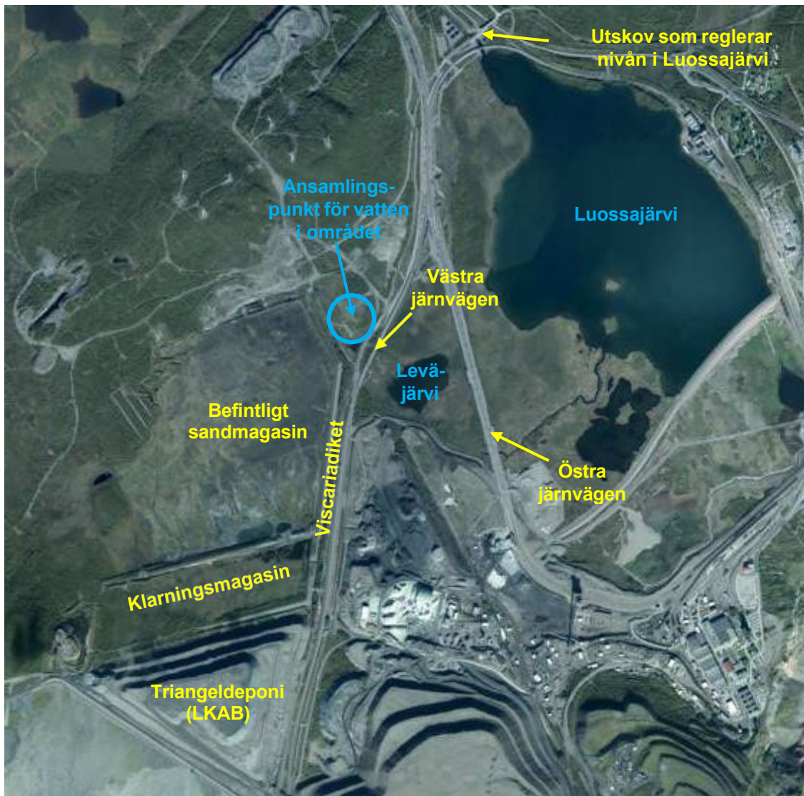
Figur 2-2. Anläggningen som den ser ut i dag med för utredningen viktiga delar utmärkta. Flygfoto taget från eniro.se.
