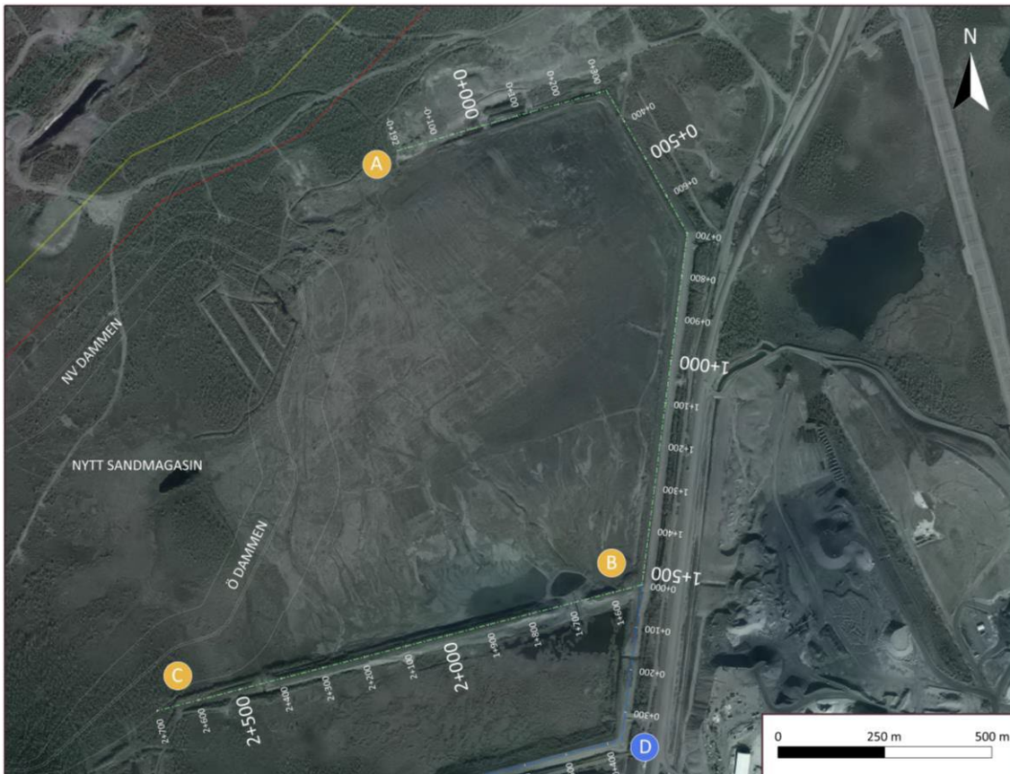
Figur 2-8. Befintligt sandmagasin. Översiktsvy. Källa: TCS.
